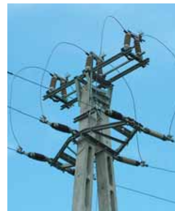
Feszítőoszlopok: a, háromszög vezetőlrendezés; b, egysíkú vezetőlrendezés fém oszlopon (a középső átkötés, mivel felül van átvezetve, veszélyes a madarakra); c, egysíkú vezetőlrendezés beton portáloszlopon – ez egy madárbarát szerkezet: mind-három átkötés a keresztartó síkja alatt van átvezetve!
