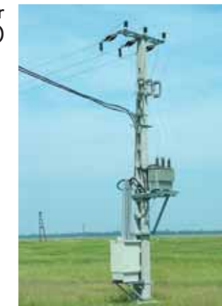
Feszítőoszlopok: a, háromszög vezetőlrendezés; b, egysíkú vezetőlrendezés fém oszlopon (a középső átkötés, mivel felül van átvezetve, veszélyes a madarakra); c, egysíkú vezetőlrendezés beton portáloszlopon – ez egy madárbarát szerkezet: mind-három átkötés a keresztartó síkja alatt van átvezetve!
