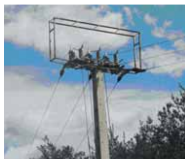
2. kép: Oszlopkapcsolóra szerelt ülöhely madaraknak. Fotó: ÉMÁSZ
