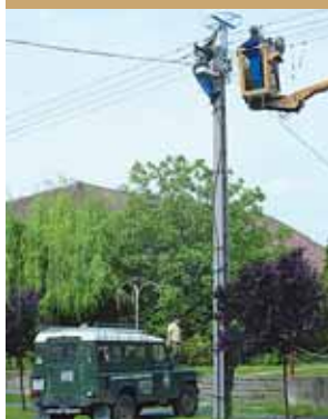
Gólyafészkek-magasító felhelyezése. Fotó: Lovászi Péter
