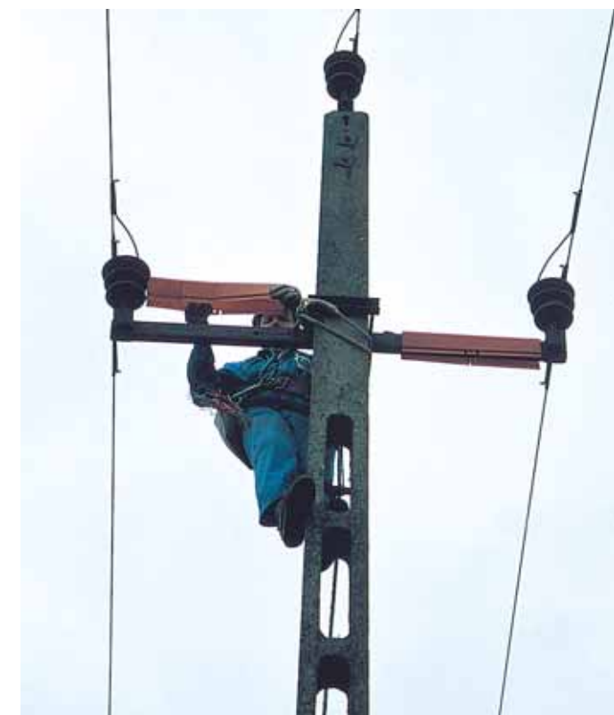
Szigetelő papucs felhelyezése tartóoszlopra. Fotó: Bagyura János
